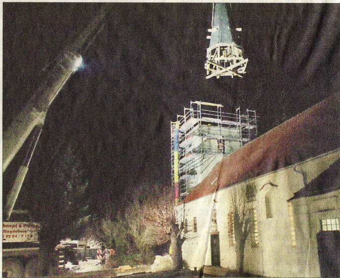
Vor etwa einem Jahr schwebte der Angeraner Kirchturm noch an einem Kranhaken. Foto: privat
